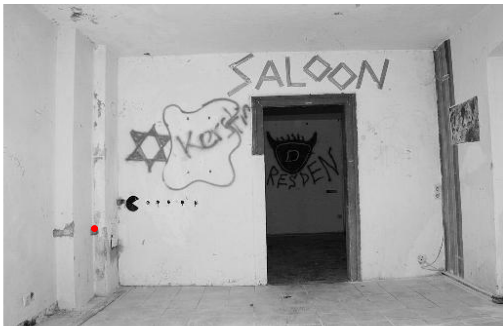
Der rote Punkt zeigt die genaue Lage der Befundstelle (Grundriß oben und Wandansicht unten)
