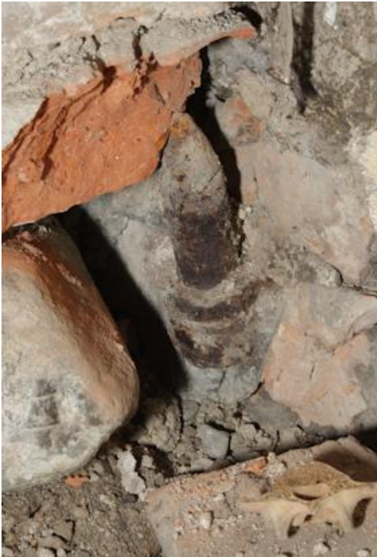
Das Foto zeigt im Detail den wohl noch bauzeitlichen Metallbolzen der Türverankerung vor der Vermauerung der großen Öffnung.
